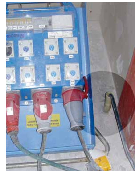
Man valde att lägga matningen till provisorisk el och belysningsystemet direkt i flytpacklet på alla våningsplan för att slippa lösa kablar. Arbetsmiljön förbättrades märkbart. Det blev mer lättstädad, kablar låg inte i vägen vilket ökade säkerheten.
