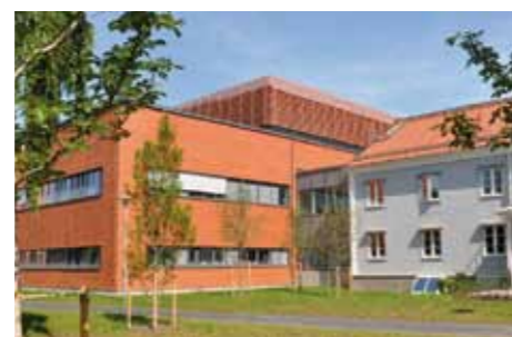
Nya moderna Hus 17 sammanbyggt med Hus 25.
