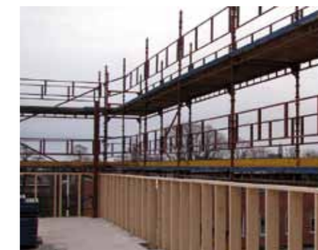
Byggnadsställning fanns på plats innan taket för att säkerställa arbetsmiljön tidigt.
