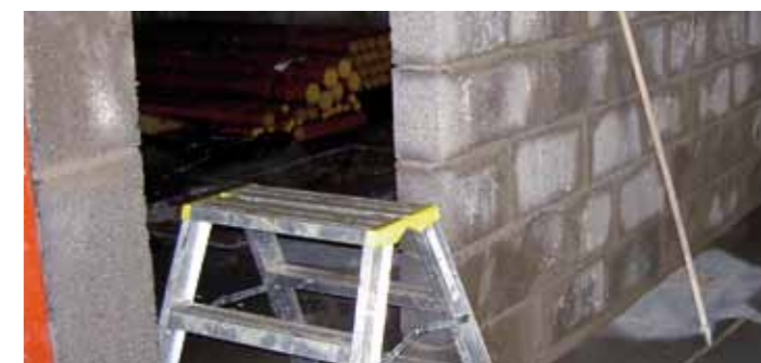
I källarplanet kom man efter diskussioner fram till att byta ut en del planerade gipsväggar till murade lecaväggar för att kunna tidigarelägga starten av installationerna. Det påverkade tidplanen för installatörerna positivt.
