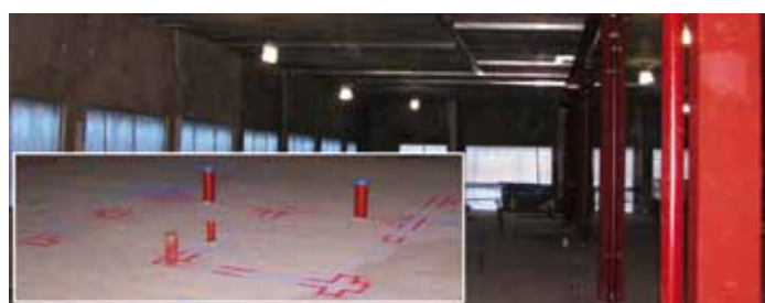
Arbetet planerades med resurser så att all utsättning på ett våningsplan i taget gjordes färdigt innan annat arbete påbörjades där. Skenorna i taket sattes upp först. Det var effektivt och åskådliggjorde hur huset skulle bli.
