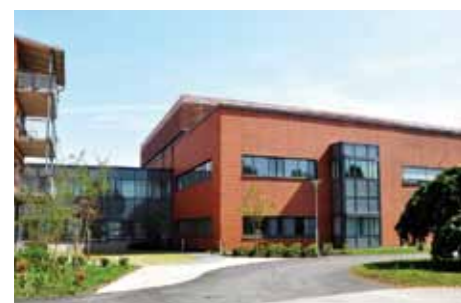
Hus 17 byggd för framtidens sjukvård.
