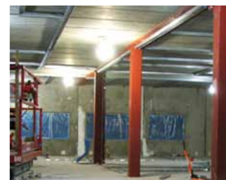
48-volts belysning med lågenergislampor och batteribackup för en ljusare och säkrare arbetsplats.
