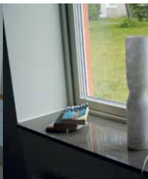
Breda fönsterbrädor efter att fönstret
