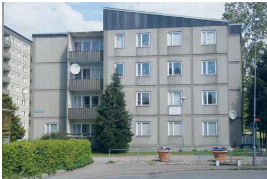
Så här såg punkthuset ut innan Backa Röd-projektet påbörjades – på sidan till höger är resultatet av arbetet.
