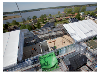
Väderskydd. De tre taksektionerna är skjutbara i längdled.
