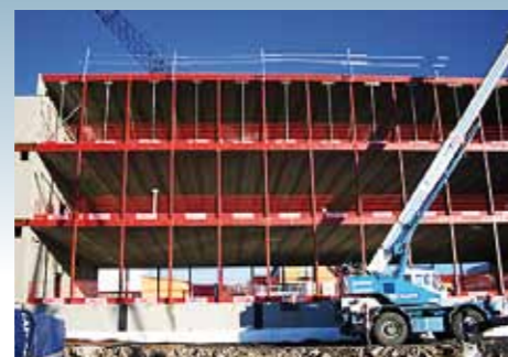
HUS C 2006-11-09 4100/6190 TIMMAR Stommen till alla 3 våningarna samt håldäck i hus C är nu på plats.
