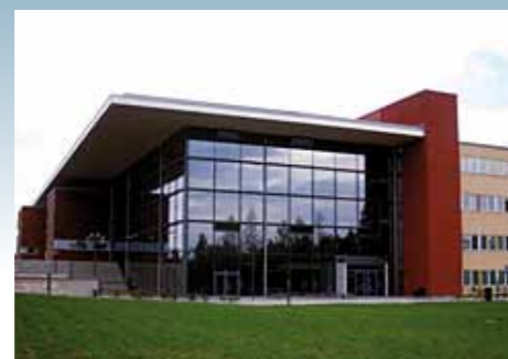
SLUTBESIKTNING 2008-07-01 77500/85000 TIMMAR Slutbesiktningen är nu klar och huset står redo för elever och lärare.
