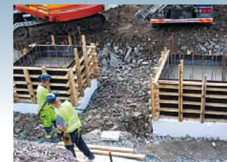
GJUTNING MICROFUNDAMENT 2006-09-11 2500/3900 TIMMAR
