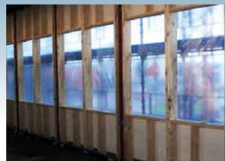
2006-11-25 5000/7500 TIMMAR Insida på utfackningsvägg på hus C plan 3.
