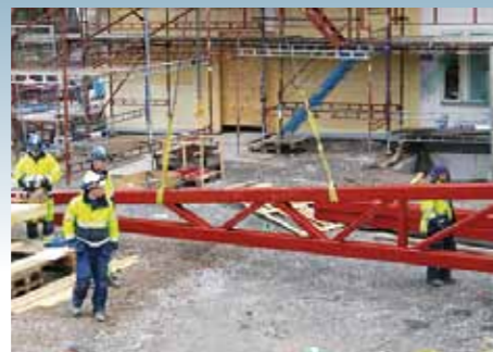
MONTAGE AV FÖRSTA TAKSTOLEN 2007-04-20 20000/24000 TIMMAR Första ståltakstolen till hus A är på väg upp för montering.
