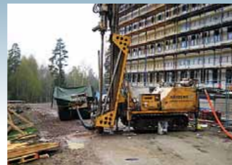
BORRVAGN 2007-04-25 21100/27500 TIMMAR Ett marklager med 35 borrhål som går ner till 200 m borrades för att sköta husets produktion av värme och kyla.
