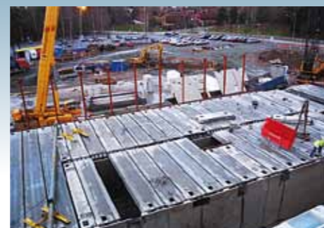
BJÄLKLAG TILL BOX 2006-11-22 4800/7300 TIMMAR Prefabbjälklag från Skanska Stomsystem lyfts på plats till box brevid hus C.
