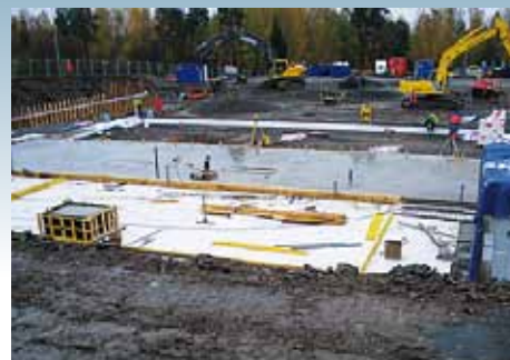
BOTTENPLATTA HUS D 2006-10-24 4400/5500 TIMMAR Halva ytan på bottenplattan till hus D färdig-gjuten.
