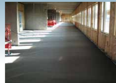
FLYTSPACKEL PLAN 5 HUS F 2007-05-03 22400/27600 TIMMAR Prefabyterna är flytspacklade och klara för golvläggning.
