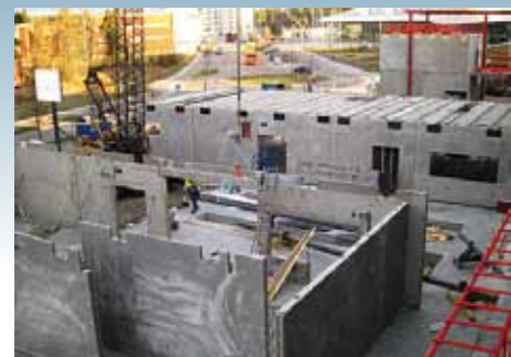
BOX 3 OCH 4 2007-04-04 19500/23000 TIMMAR Prefabstomme pågår till box 3 och 4 inne i hus A.
