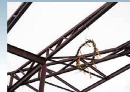
TAKSTOLSKRANS 2007-05-30 23000/33000 TIMMAR Som seden lyder hissas takstolskransen när takstolarna är uppe.
