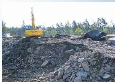
BYGGNATIONEN STARTAR 2006-08-01 0/0 TIMMAR
