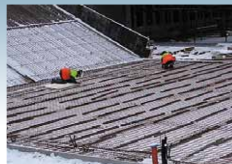
GOLVVÄRME HUS A 2007-02-14 12600/16500 TIMMAR
