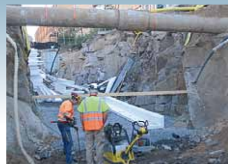
SCHAKTNING UNDER VÄRMEKULVERT 2006-08-18 2000/2600 TIMMAR
