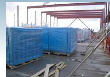
FLÄKTRUM 2007-01-18 7400/11000 TIMMAR Ventilationsaggregaten lyfts in innan arbetet av rummet fortskrider högst upp på hus D.
