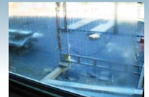
VATTEN I FÖNSTER HUS F PLAN 2 2007-06-04 24000/35100 TIMMAR Fabrikationsfel upptäcktes på en handfull fönster som skickades tillbaka till tillverkaren.
