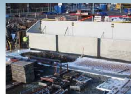
UNDER TRAPPAN 2007-01-18 7400/11000 TIMMAR Stommen till trappan i hus A (brevid ägget) är klart. Utrymmet under trappan kommer nyttjas till rum.
