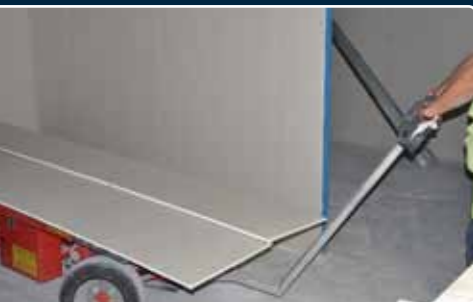
En elektrisk gipsvagn såg till att gipsen kom till rätt plats i huset.
