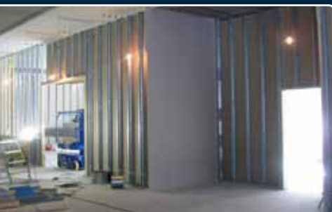
Arbetet med att sätta upp gipsen genomförs.
