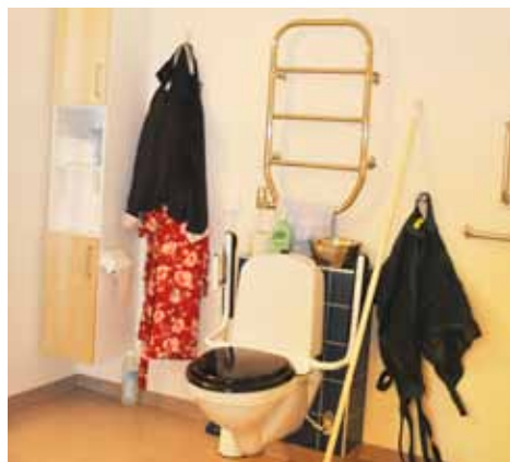
Nybyggda badrum med lättillgänglig toalett, dusch och tvättmaskin finns i alla lägenheter.
